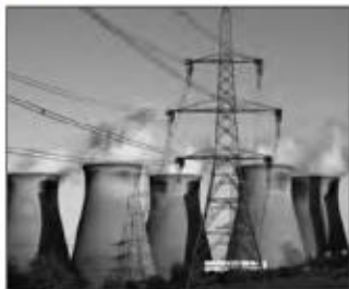
Nhà máy điện © Vol. 57/Photo Disc.
