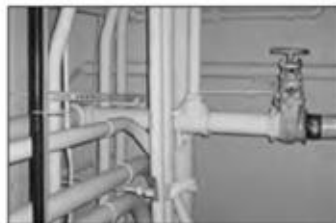
Hệ thống ống nước Photo by John M. Cimbal.
